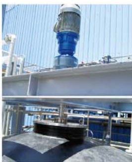
化工儲槽(格蘭軸封)
