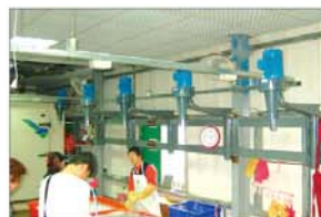
冷凍食品設備
